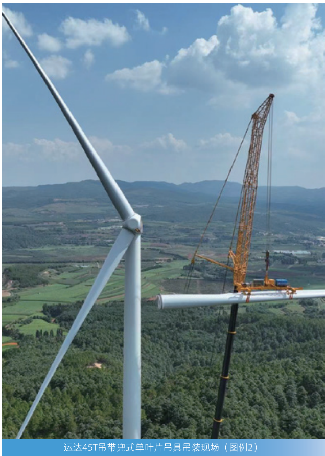
运达45T吊带兜式单叶片吊具吊装现场（图例2）
