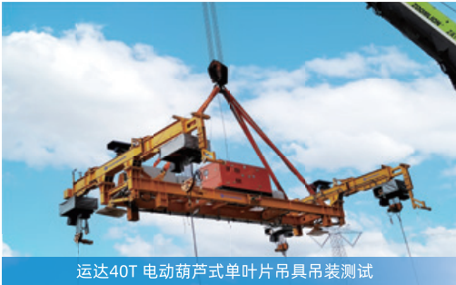
运达40T 电动葫芦式单叶片吊具吊装测试
