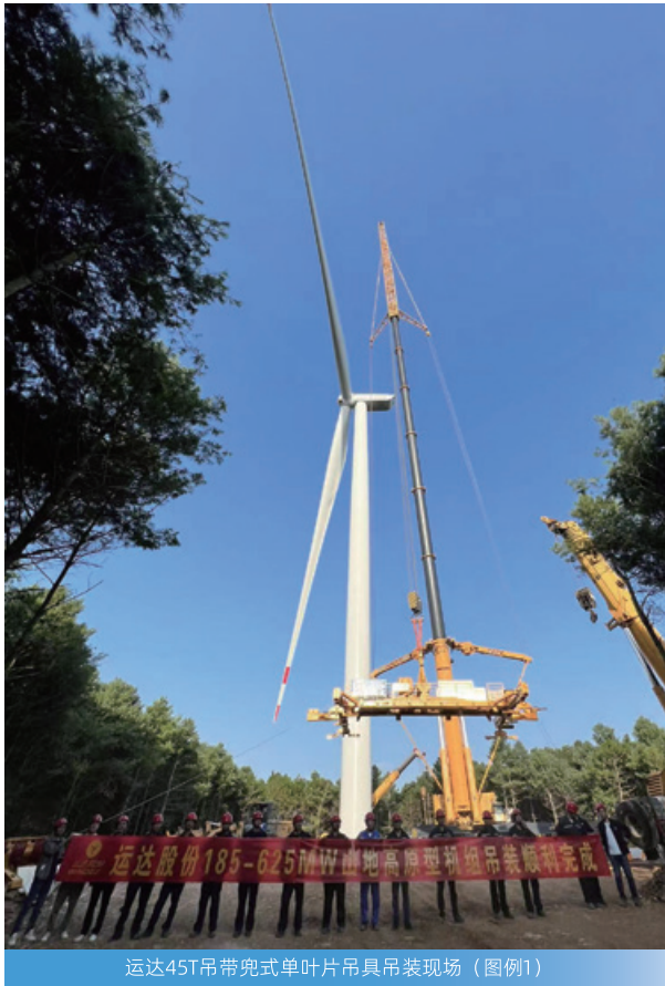
运达45T吊带兜式单叶片吊具吊装现场（图例1）
