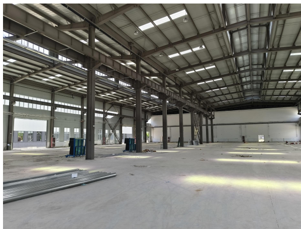
生产车间现状
